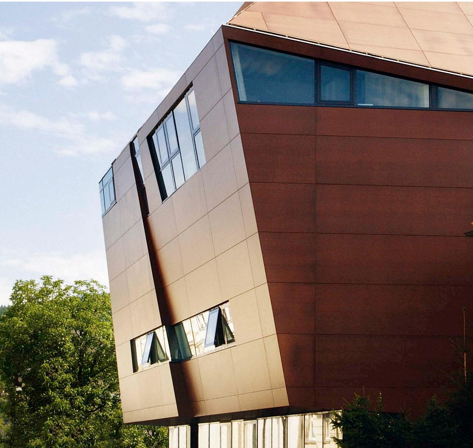
Fugenprofile (Sickenprofil) vertikal und horizontal
