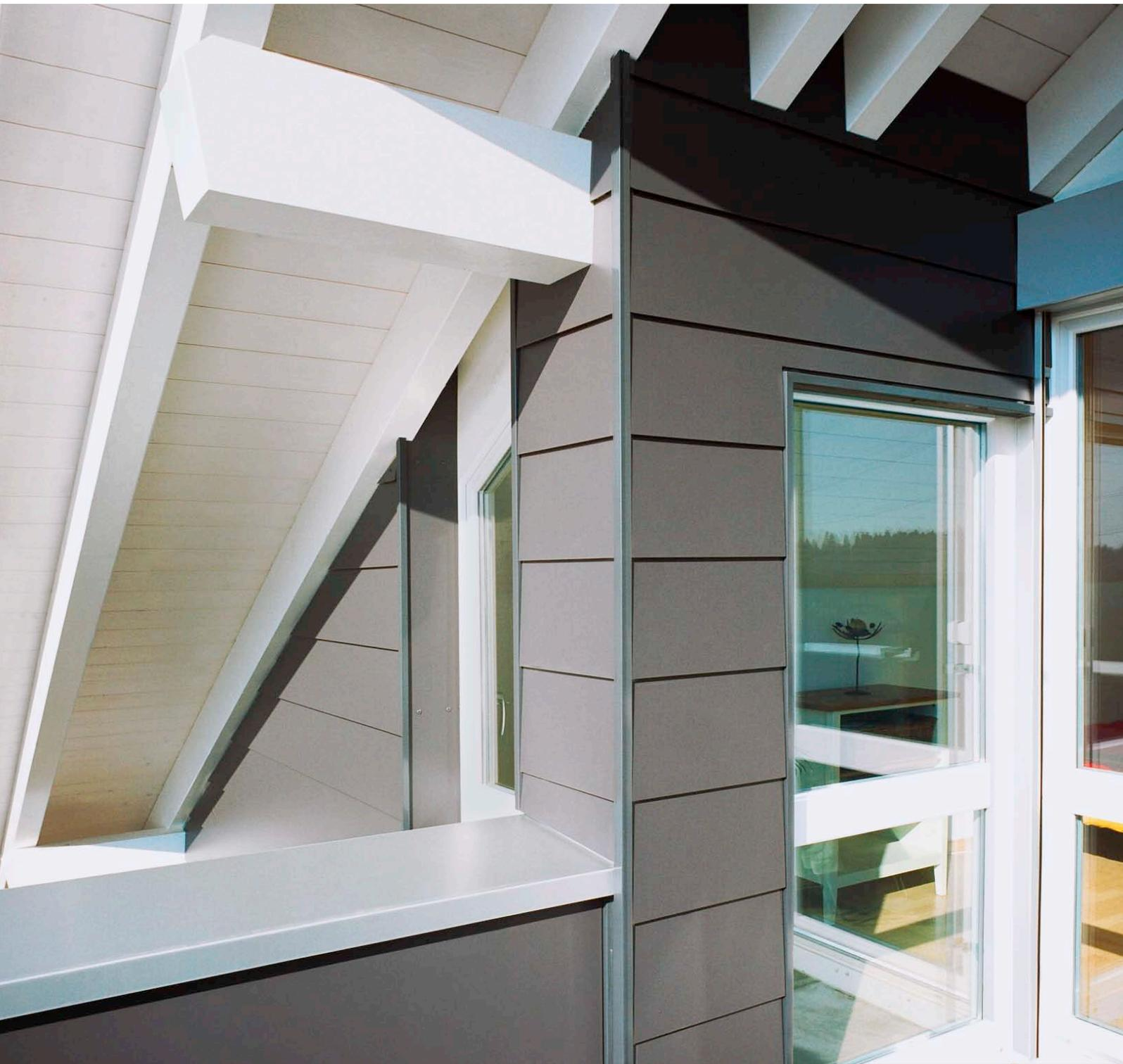
Kantenprofile ohne Schnittkantenüberdeckung
