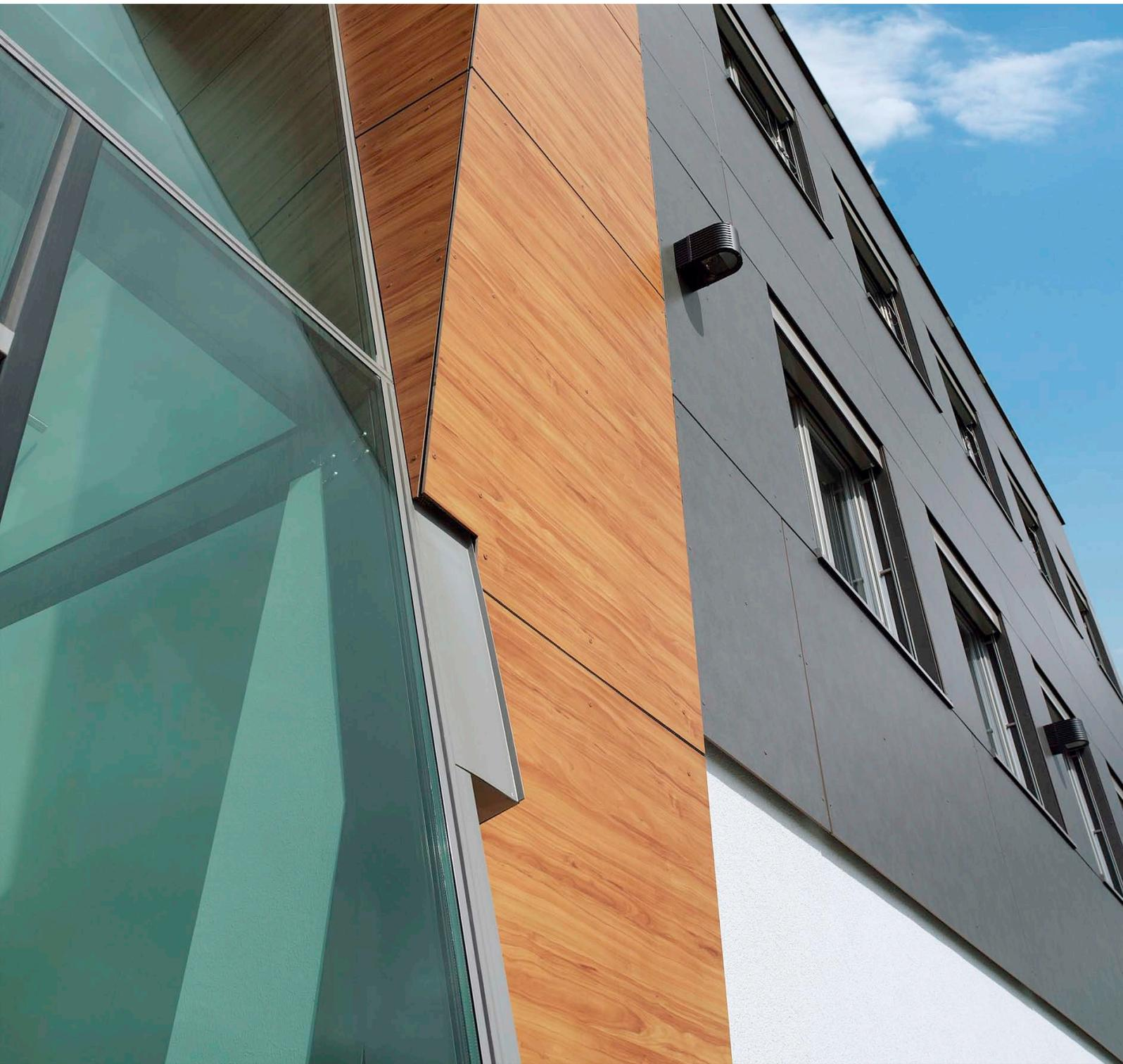
Anschlussprofile mit Schnittkantenüberdeckung
